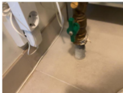
Synlig membran rundt vannledning
