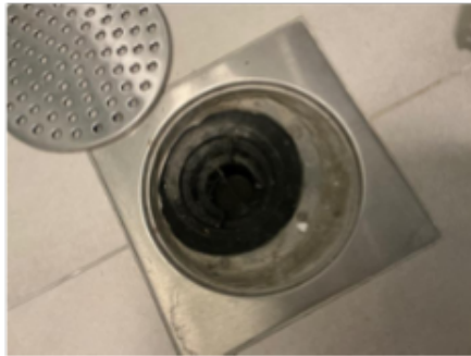
Synlig membran i sluk
