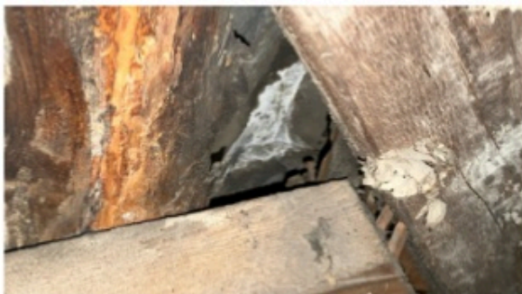
Fuktskader i undertaket på loft
