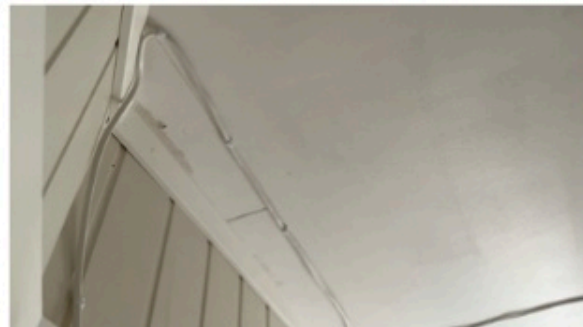
Ufagmessig festing av ledninger
