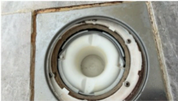
Synlig membran i sluk.
