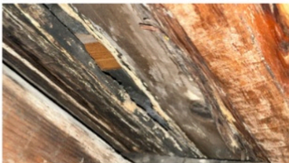
Fuktskader i undertaket på loft
